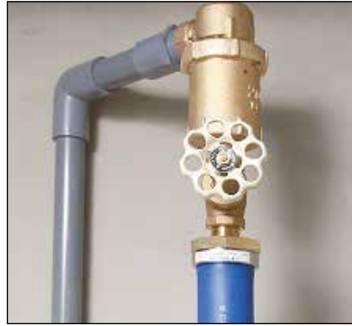
●最上階:吸排気弁取付け
