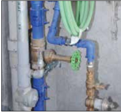
●最下階:ゲートバルブ取付け
