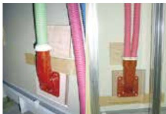
ユニットバス躯体貫通部
