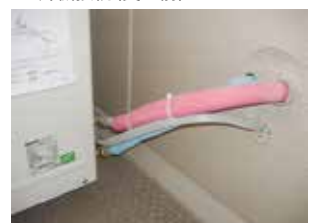
室外機接続(養生前)
