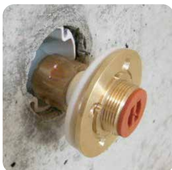
継手の固定
