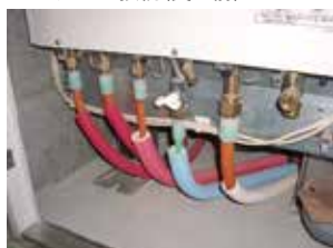
エコキュート接続(養生前)
