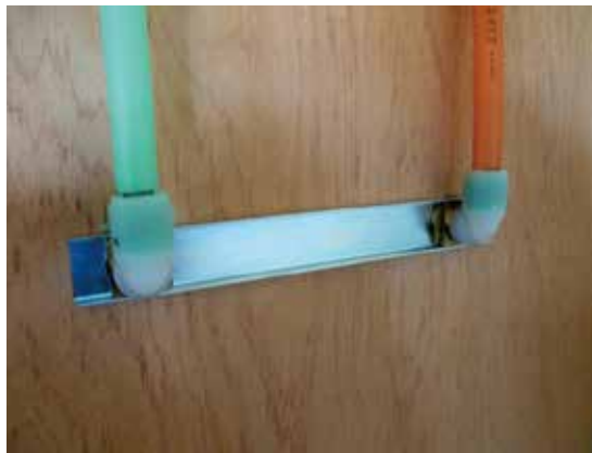
パネル継手+固定チャンネル
