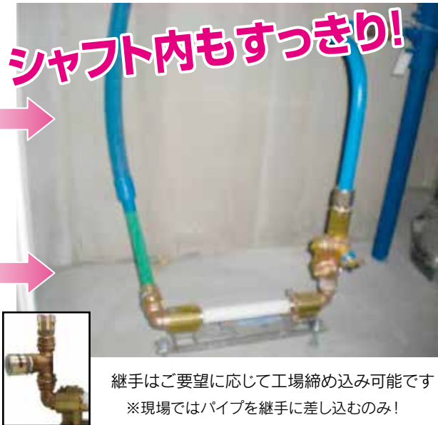
メータユニットから検査する事により、 テスト用継手不要!
