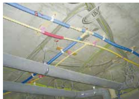
給水:保温材、給湯:部分養生
