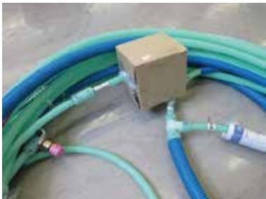
プレハブ取付け状態
