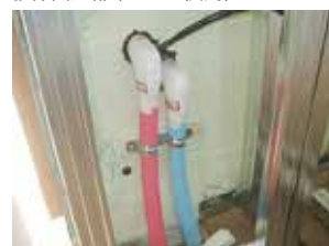
躯体貫通部(エルボ使用)
