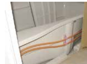
浴室内 サドル固定
